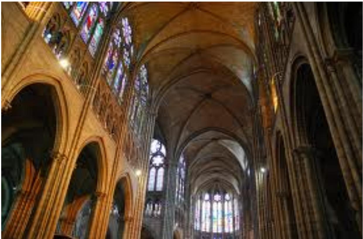
I costruttori medioevali riescono a realizzare finestre a traforo in cui ogni singola parte deve coincidere perfettamente, senza usare la malta e senza lasciare spazi.
